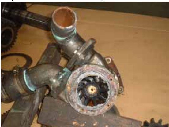
開放した海水ポンプ
