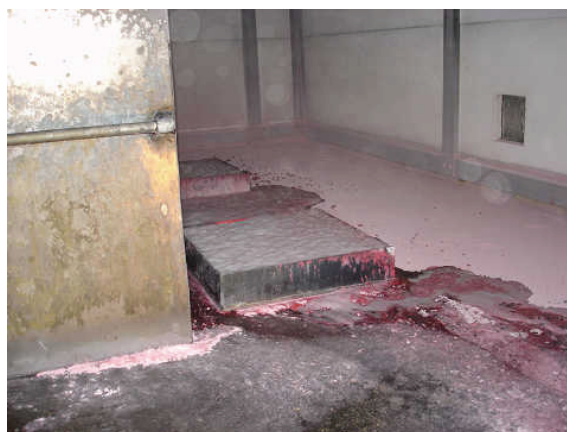
強制消火後の火皿の様子
