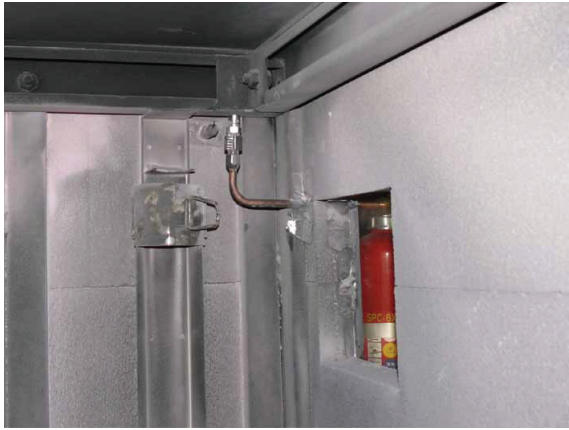
手動拡散型消火器 (模擬機関室内部)
