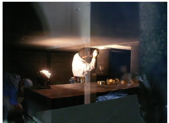
天井パネル破損（交換作業）
