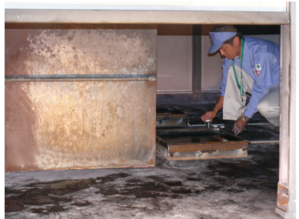
点火用ヘプタン投入
