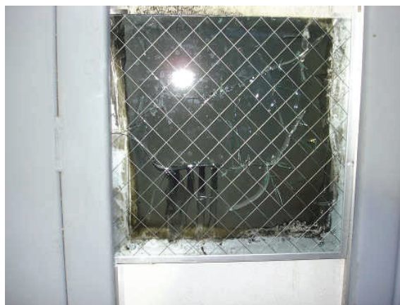
実験後の網入りガラスの様子 (全て割れた)
