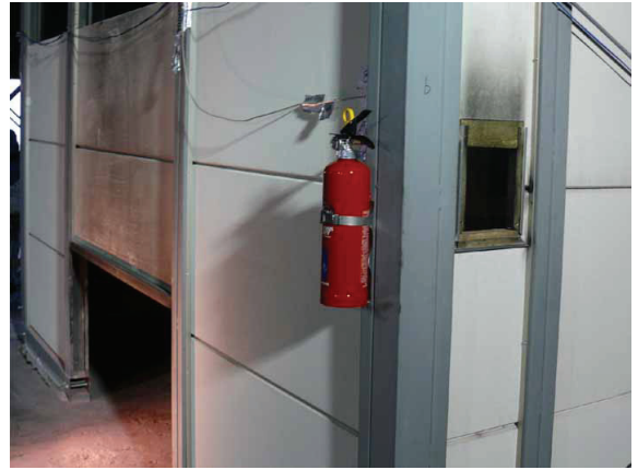
手動拡散型消火器 (模擬機関室外部)
