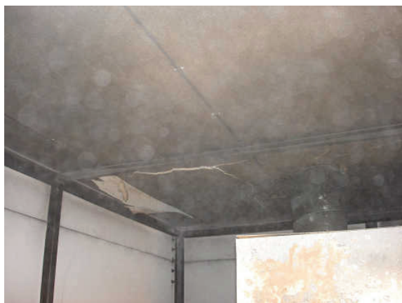
天井ボードの亀裂 (開口) の様子
