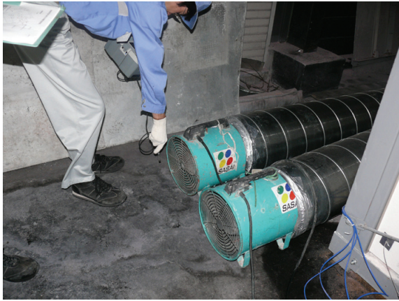
ダクト風速測定
