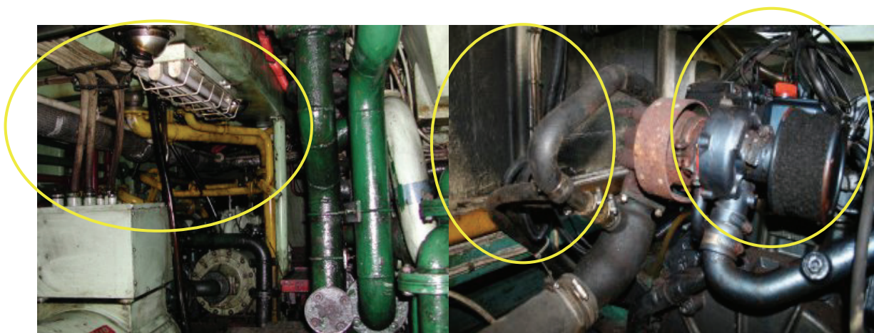
機関室の配線
