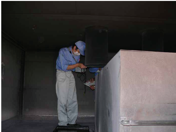
ダクト風速測定の様子
