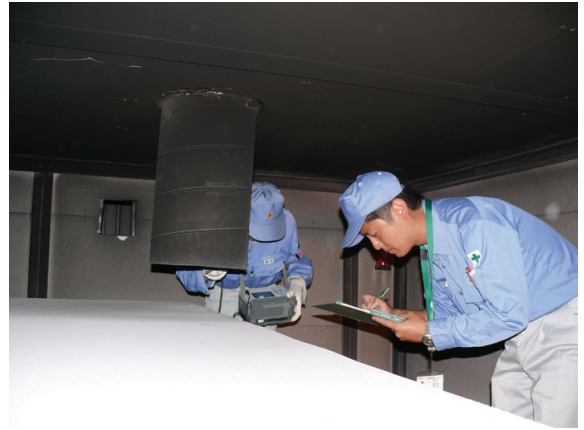
ダクト吸気量測定
