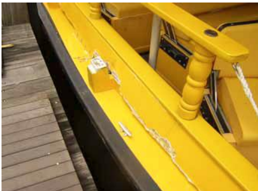
(右舷側)バッテリー区画の船側外板と甲板の接合部剥離
