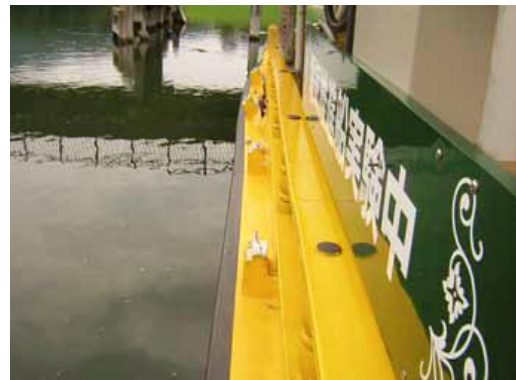
(左舷側)バッテリー区画の船側外板と甲板の接合部剥離
