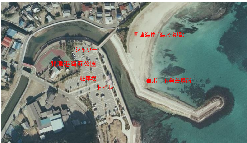
興津港海浜公園の施設と、ミニボートが利用する発着場所
