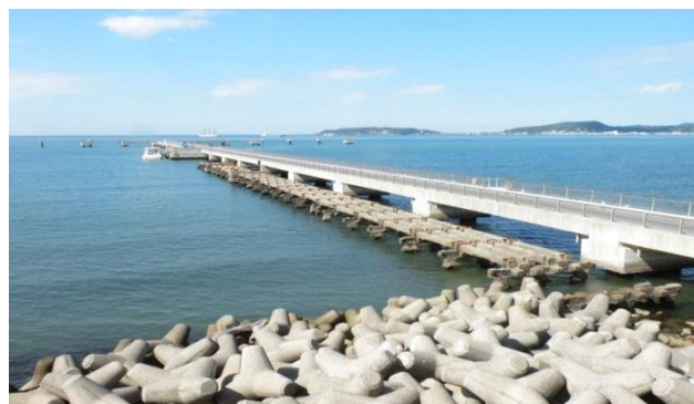
平成 22 年に完成した館山港の多目的観光棧橋(長さ 400m)
