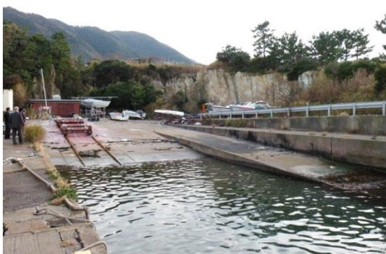
ミニボートが利用する鷹巣港の修理用斜路（左）
