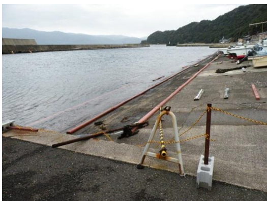
ミニボートが利用する、立石漁港の船揚場
