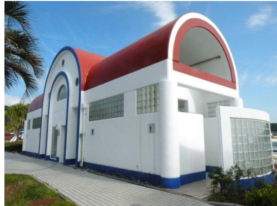
駐車場に作られたトイレ（シャワーも付いている）
