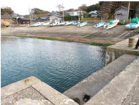
ミニボートが利用する鷹巣漁港の階段状の係船岸壁
