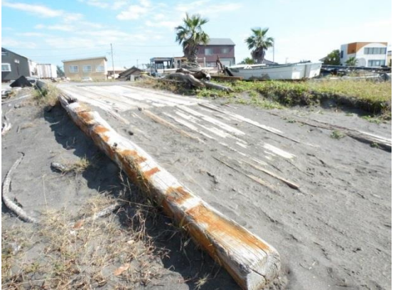
ボートの揚げ降ろしに利用されている手作りの斜路
