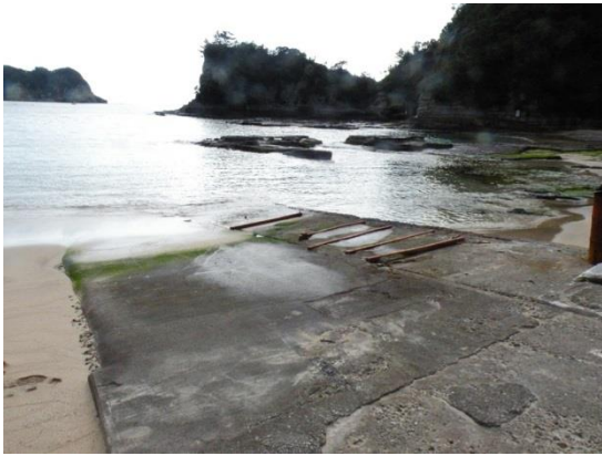
守谷漁港の斜路（スロープ）
