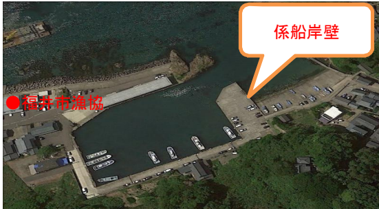
ミニボートが利用する鷹巣漁港の階段状の係船護岸
