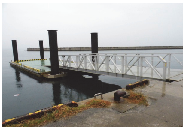
吉田港に愛知県が設置した浮棧橋
