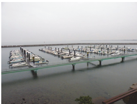
ボートパークの全景。4 基の栈橋が設置されている
